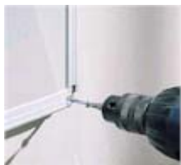
Fixation au 4 coins par cache vis
